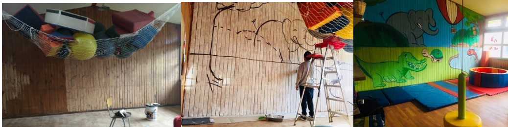
Foto 7: proceso de mejora de sala de rehabilitación
